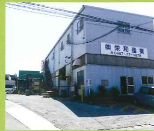
本社工場。神奈川県(綾瀬市)と静岡県に拠点を置き全10工場を有する
